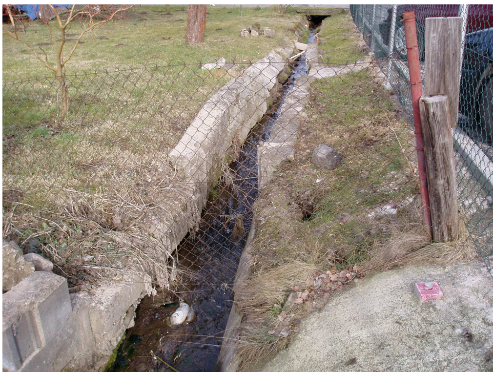
Obr. 3 SO 1.1 nekapacitní pobožené koryto na p.č. 1138/1
