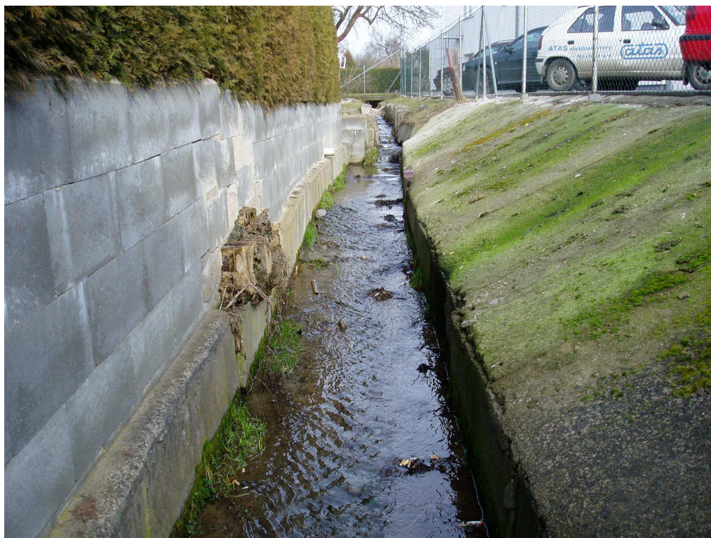
Obr. 2. SO 1.1 pravobřežní zeď zůstane zachovaná, betonová šikmina bude odstraněna
