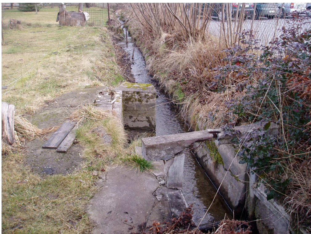
Obr. 5. SO 1.3 nekapacitní koryto s dožitými stavbami na p.č. 1137/4
