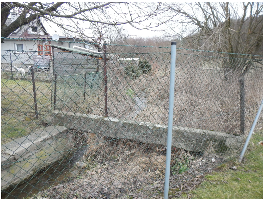
Obr. 7. SO 1.4 dožitá nádřka na rozhraní p.č. 1137/5 a 1137/7
